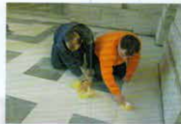
MARMORBODEN. Rutschhemmung und Schutz in den Arkaden
