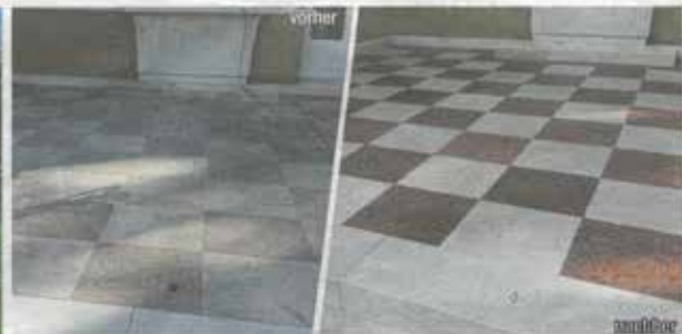
Bodenbelag vor- und nach der Reinigung, Pflege und Imprägnierung
