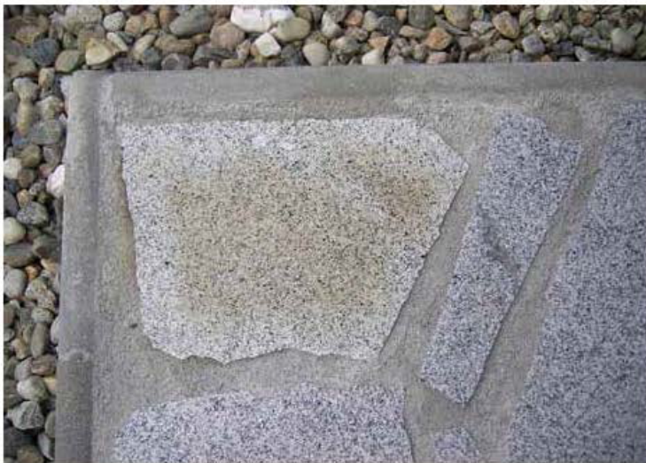
4 Gelbe Flecken bei einem chinesischen Granit auf einer Terrasse vor der Behandlung ...
