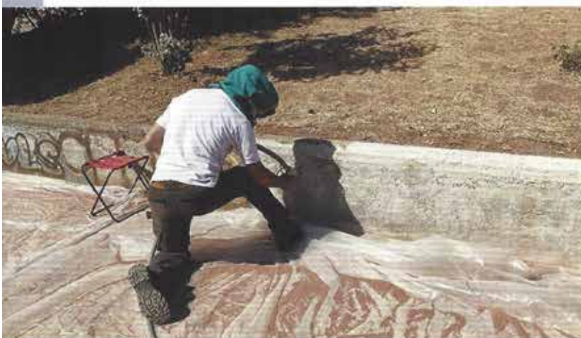
Die Oberfläche wird mit Natriumkarbonat gestrahlt und danach mit saurem Graffiti-Entferner behandelt. 30 Minuten Einwirkzeit reichen bei den meisten Flächen
