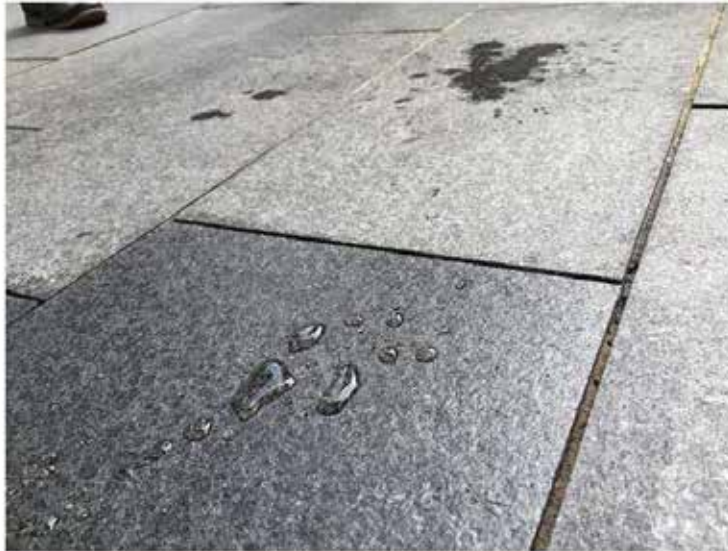
Imprägnierung mit Abperleffekt (vorn).
