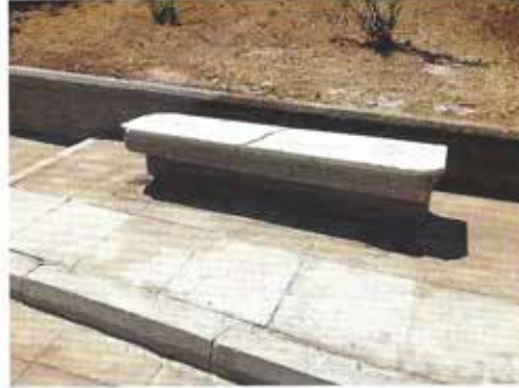
Um den sauren Graffiti-Entferner zu neutralisieren, wird zum Schluss mit einem Intensivreiniger gearbeitet
