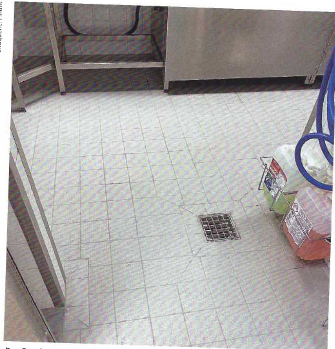
Das Ergebnis: saubere Bodenfliesen ohne Epoxidharzrückstände
