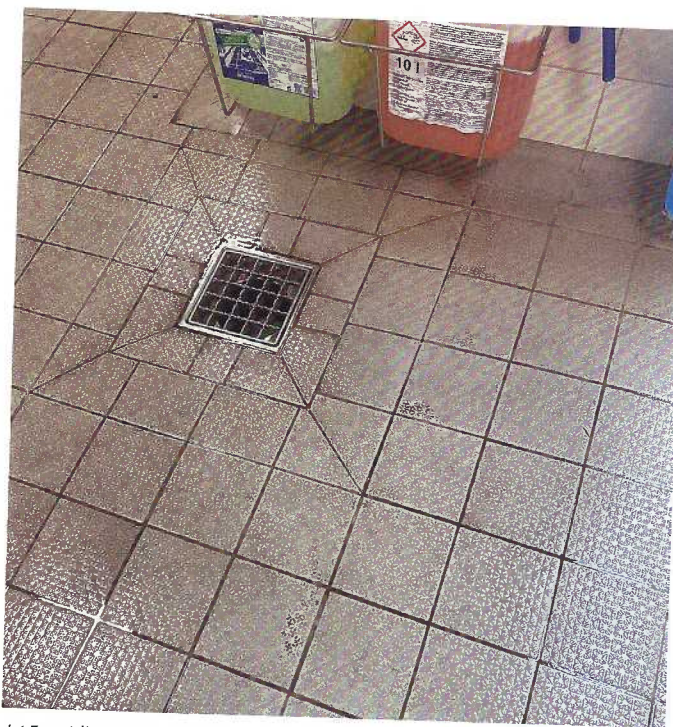
Ist Epoxidharz ausgehärtet, ist die Entfernung mit üblichen Reinigungsmethoden kaum noch möglich.
