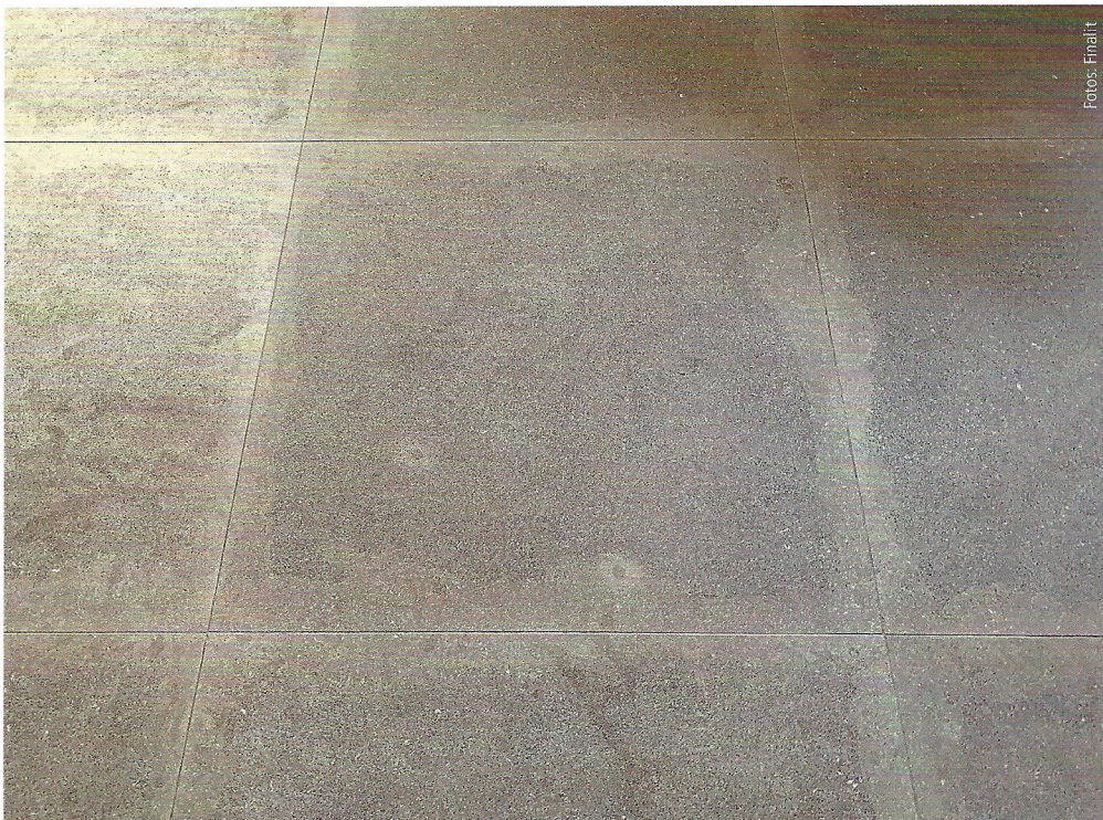
Keine Fugenrandverfärbung nach der Behandlung mit dem Spezialreiniger
