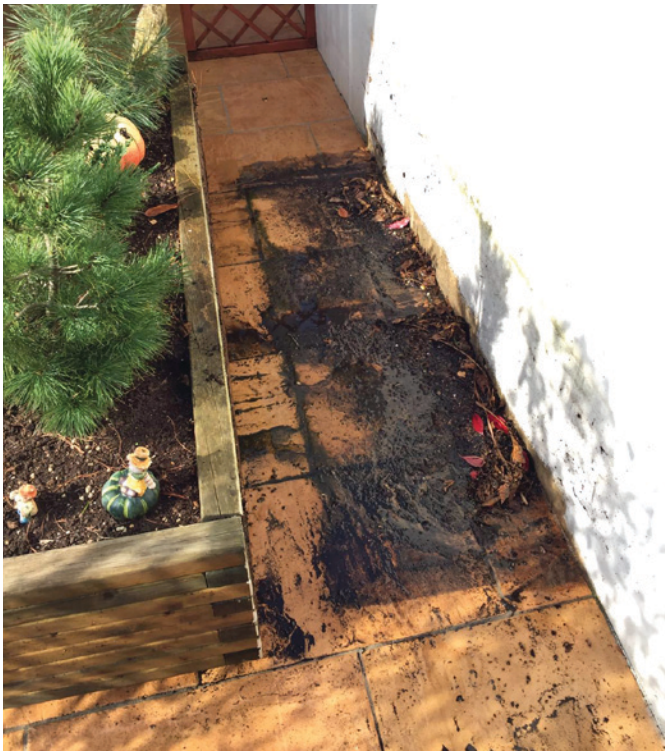
Platten aus Quarzit im Außenbereich vor und nach der Reinigung.
